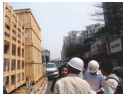
(生活变频泵进场验收)
