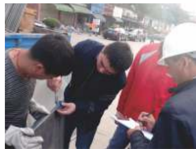
(不锈钢水箱进场验收)
